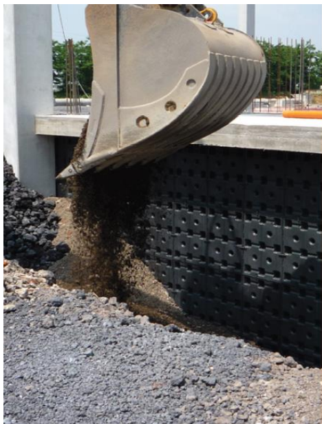
Aplikace u opěrné stěny
