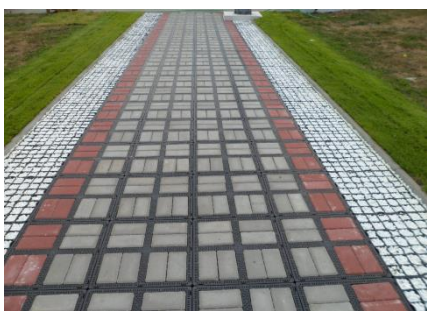
příklad pokládky Greenall Stone ve fázi po výplni
