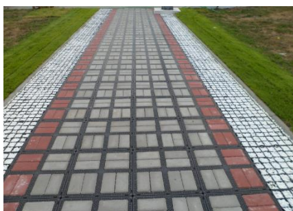
příklad pokládky GREENall Stone v kombinaci se zatrávňovacími tvárnici Greenall GI50 ve fázi po výplni
